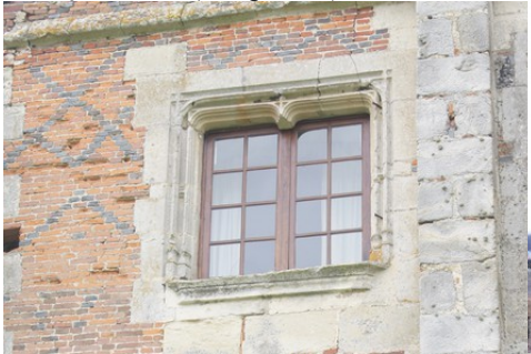
Le détail d'une ancienne baie à meneaux
