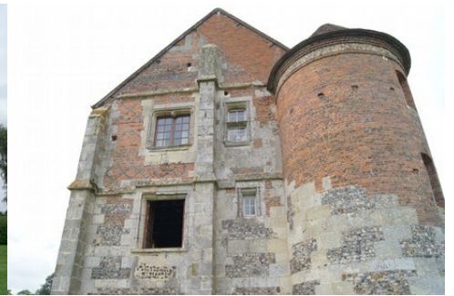
Le pignon est (vue proche)
